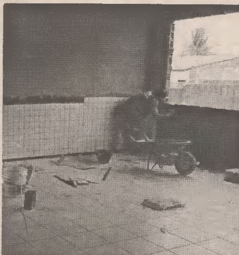
Operário trabalha no serviço de acabamento
